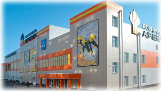
Строительство Ледового Дворца «Роснефть-Арена»
