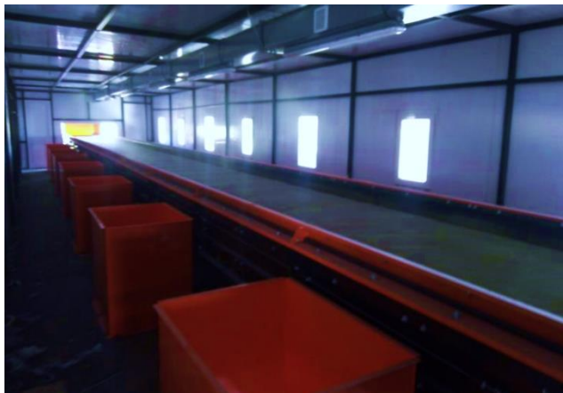
Строительство линии мусоросортировки
