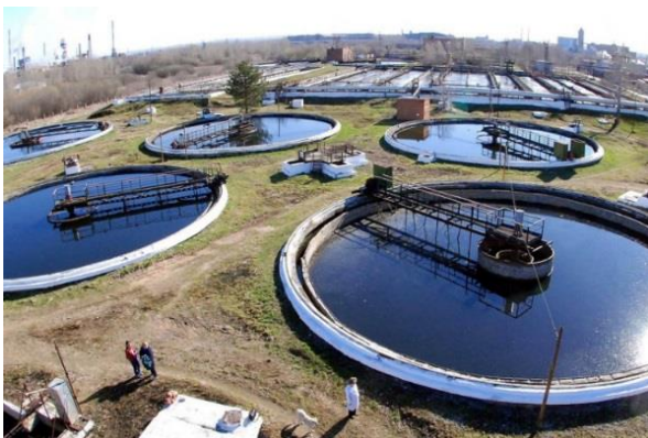
Реконструкция очистных сооружений в рамках федерального проекта «Оздоровление Волги»
