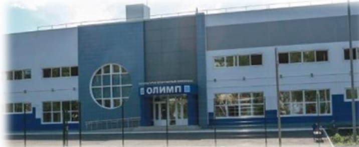
Строительство ФСК «Олимп»
