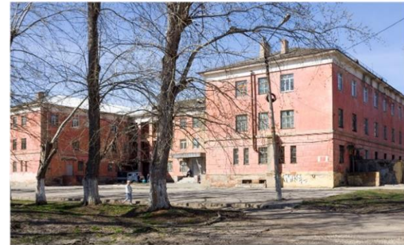
Реконструкция здания под школу
